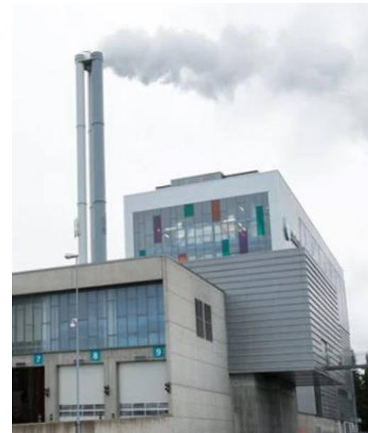
Fjernvarmeanlegget på Heimdal dekker 30 prosent av byens oppvarmingsbehov.
