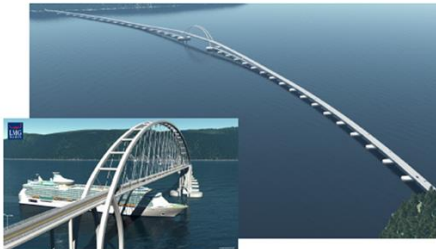
A: Flytebru med hogbru skipspassasje
