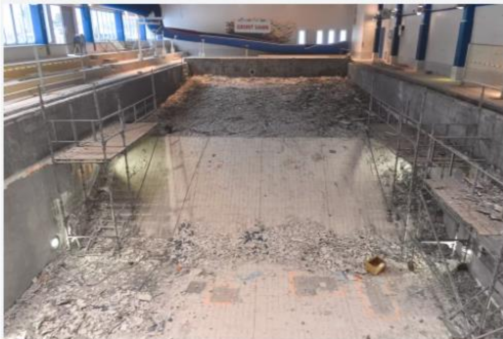
Riving av flis i svømmebassenget i Ørlandshallen på Brekstad er i full gang. FOTO: OLA BERNSTAD
